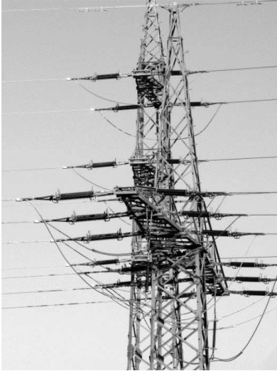
Abb. 7.2 Für die Stromversorgung werden regenerative Quellen benötigt
